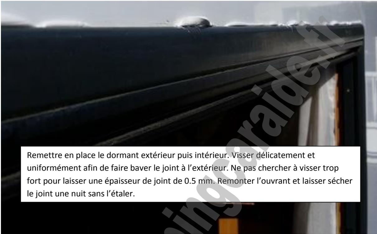
Remettre en place le dormant extérieur puis intérieur. Visser délicatement et uniformément afin de faire baver le joint à l'extérieur. Ne pas chercher à visser trop fort pour laisser une épaisseur de joint de 0.5 mm. Remonter l'ouvrant et laisser sécher le joint une nuit sans l'étaler.
