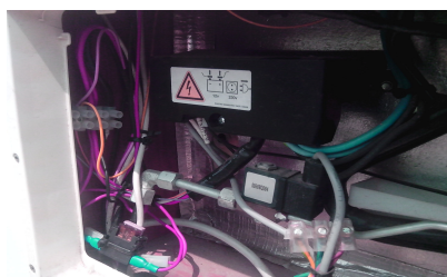
Vue alimentation 12 V sur domino situé au bas du frigo
