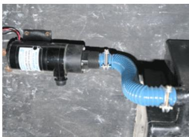
L'évacuateur étant une pompe, il pourra être disposé **sur un plan plus élevé que la sortie de vidange** de réservoir. Pour le branchement de l'arrivée, il suffit de supprimer l'évacuation existante du réservoir et de la remplacer par un tuyau annelé de 40 mm de diamètre..
