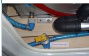
Soupape de sûreté du chauffe-eau Alde
